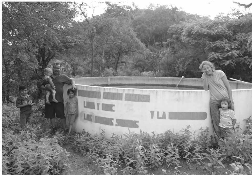
Bacino d'accumulo d'acqua a Trampitas - 2012, recentemente riverniciato
